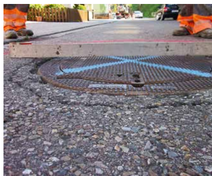
Abgesunkene Schachtabdeckung
