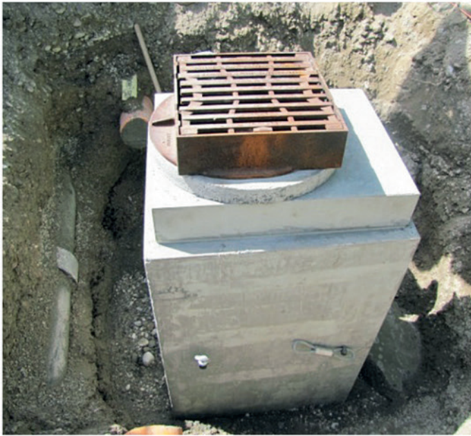
BUDAVINCI® Typ Z wird auf fertige Höhe gesetzt.
