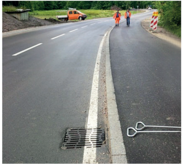
Der fertig eingebaute BUDAVINCI® Typ Z ist unter dem Aufsatz positioniert.
