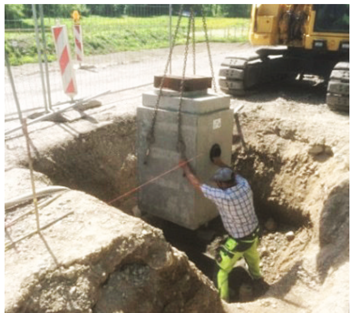
Ausrichten des BUDAVINCI® Typ Z an der zukünftigen Bordsteinkante.
